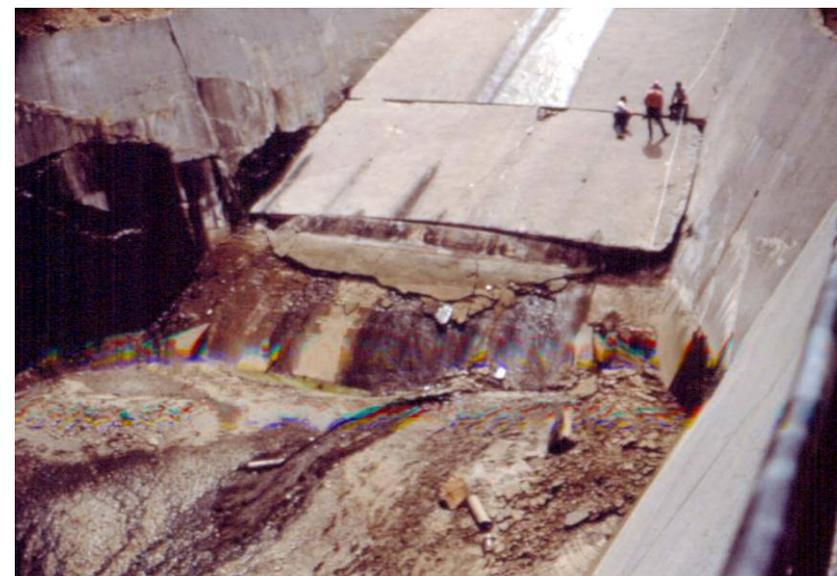
*(juntas defeituosas, desalinhamentos da soleira, deslocamento de lajes e erosão da fundação))*
